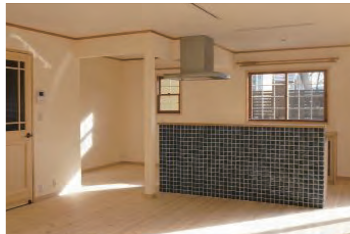
50 リビング | 漆喰塗り・床張り替え・二重サッシ交換
