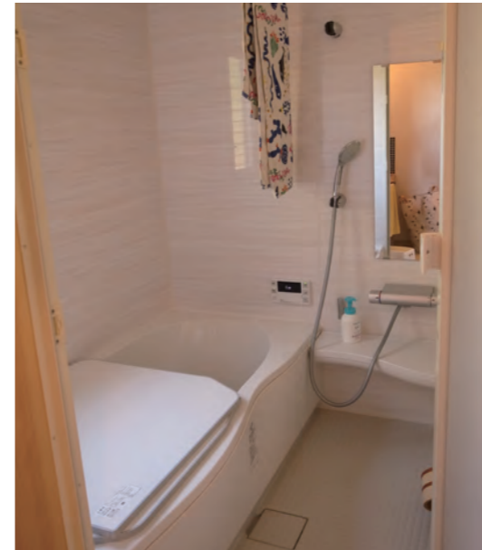
風呂場 | 設備取り替え
