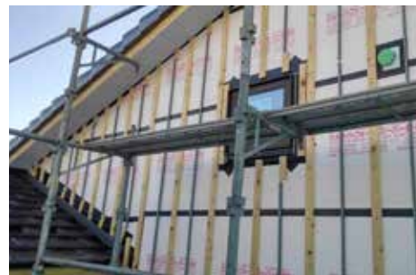
施工中 | 外断熱
