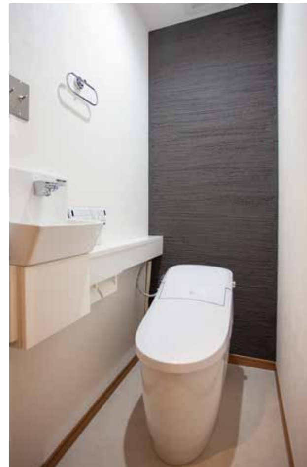
トイレ | 設備交換
