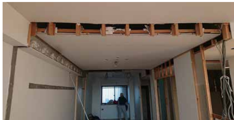
施工中[リビングから北洋室]
