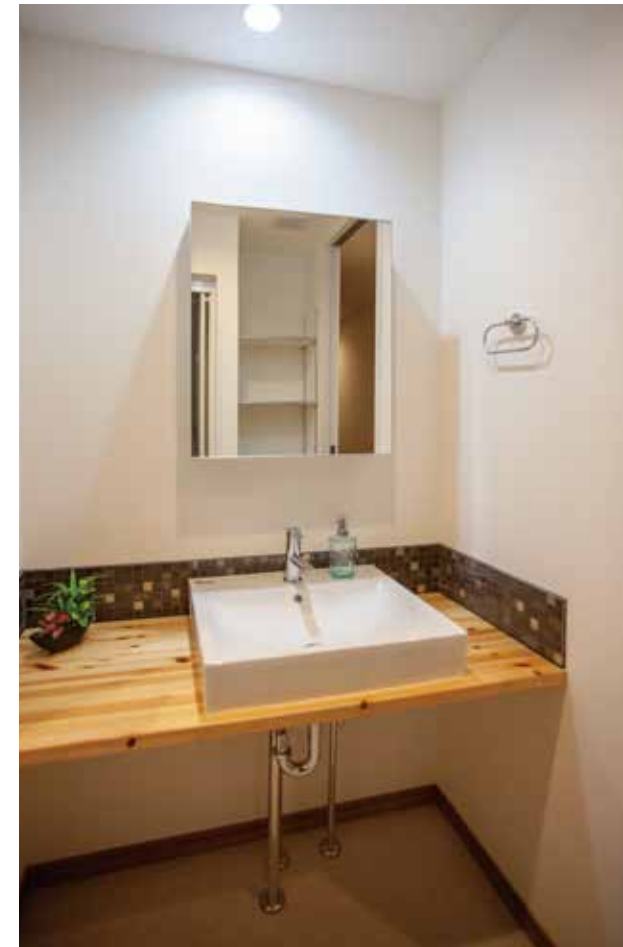
洗面 | 設備交換
