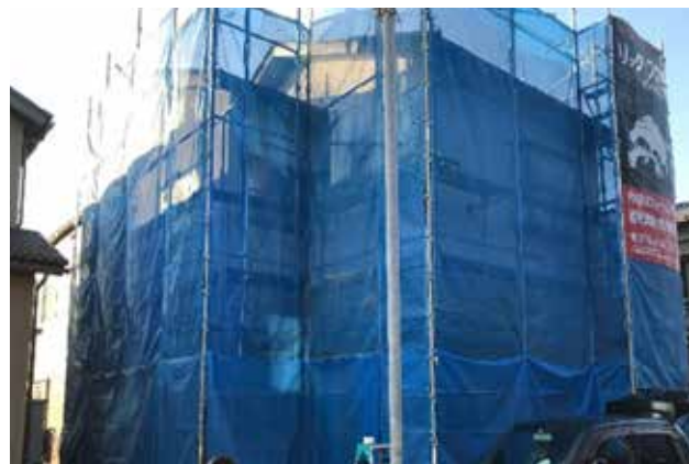
80 屋根、外壁 | 塗装
