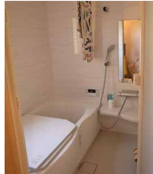
風呂場 | 設備取り替え
