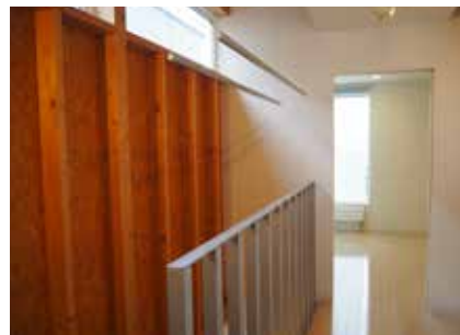
2階廊下 | クロス張り替え
