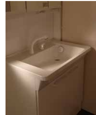
洗面台 | 設備取り替え
