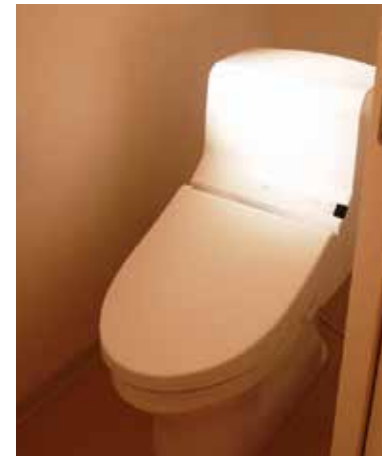
トイレ | 設備取り替え
