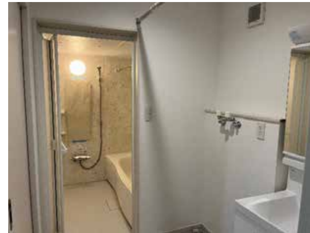
風呂・脱衣場 | 設備取り替え 改修後
