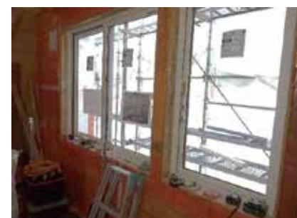
窓改修 | 樹脂サッシへの交換
