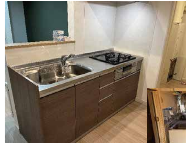
キッチン | 設備取り替え 改修後
