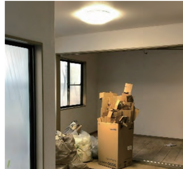
建物内装 | クロス全面張替
