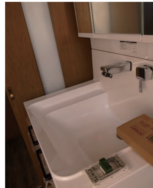
洗面台 | 設備交換
