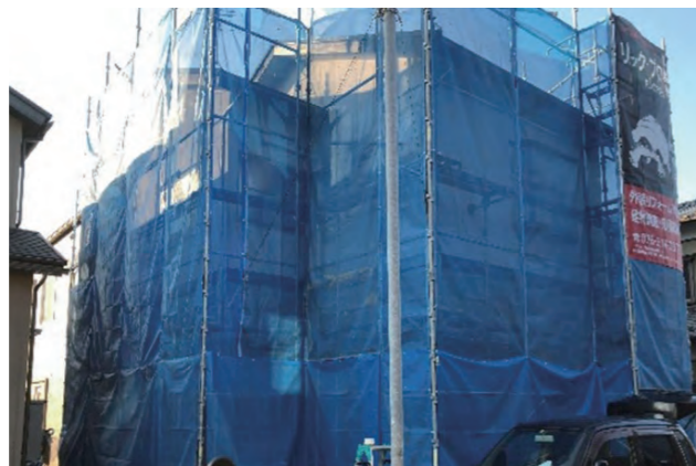
70 屋根、外壁 | 塗装
