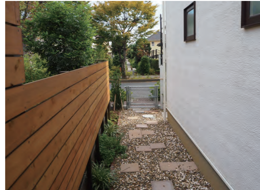
路地庭 | 柵、敷石設置
