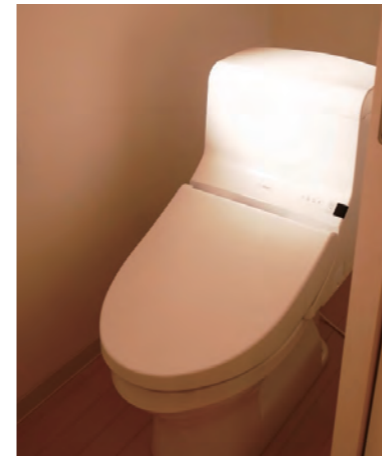
トイレ | 設備取り替え
