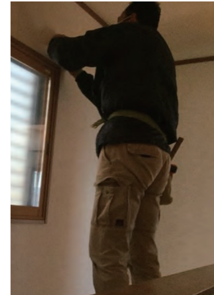
2Fホール | 内装クロス張り替え
