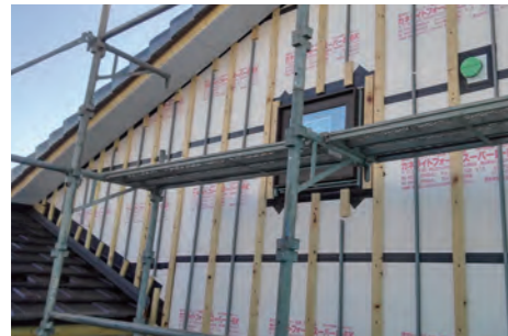
施工中 | 外断熱
