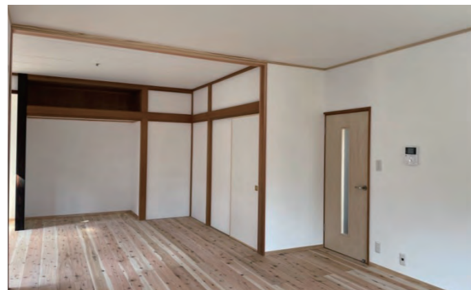
54 リビング | 壁漆喰・床無垢板へ張り替え
