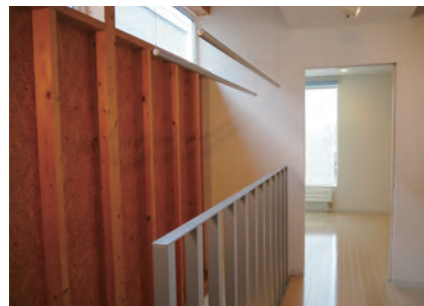
2階廊下 | クロス張り替え
