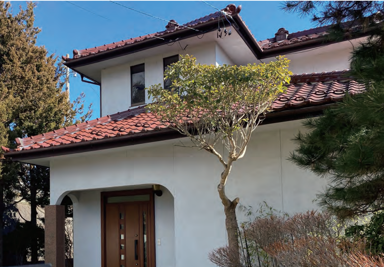
外観 | 窓廻りモルタル補修 床下 | 防腐・防蟻処理 玄関 | 断熱親子ドアに交換
