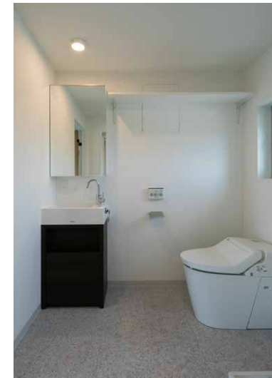
トイレ | 設備取り替え
