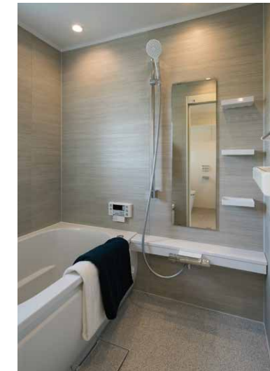
風呂場 | 設備取り替え
