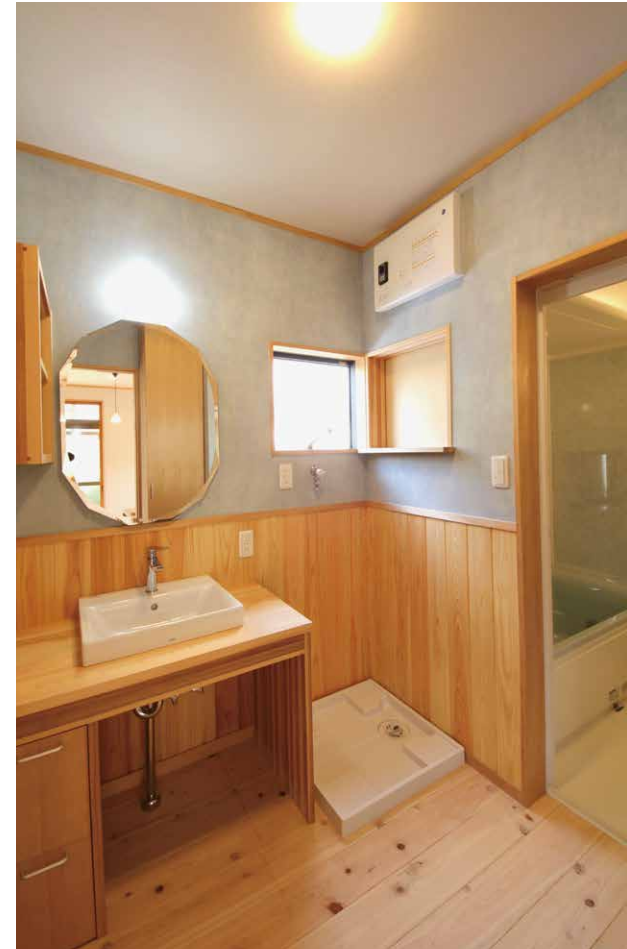
洗面室 | 設備取り替え
