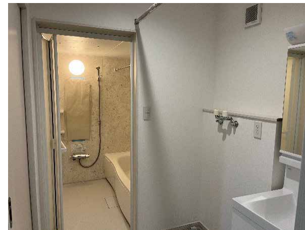
風呂・脱衣場 | 設備取り替え 改修後
