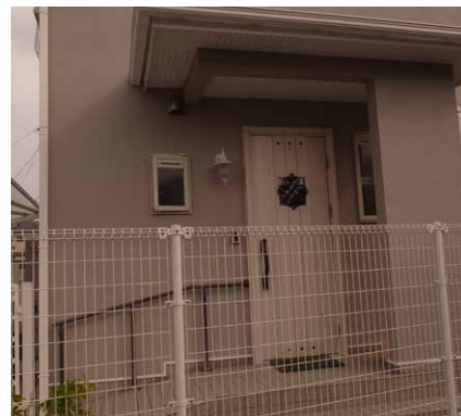
玄関扉 | 交換 外壁 | 塗装
