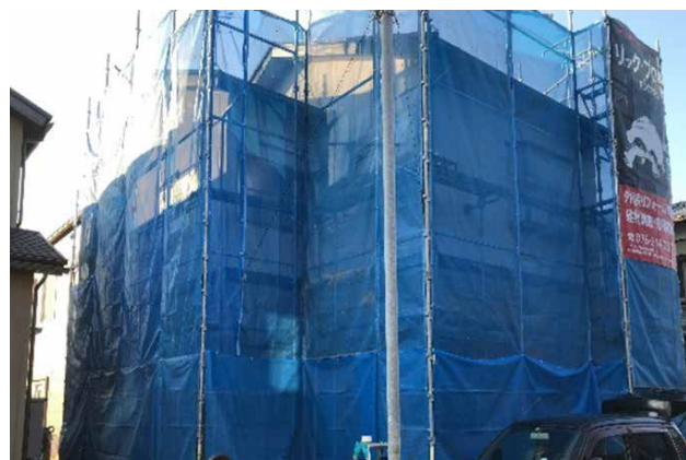
80 屋根、外壁 | 塗装
