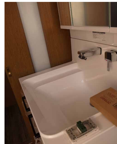
洗面台 | 設備交換
