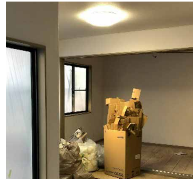
建物内装 | クロス全面張替
