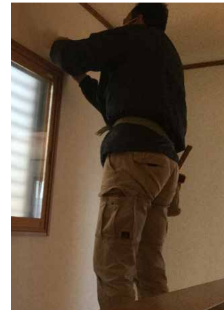
2Fホール | 内装クロス張り替え
