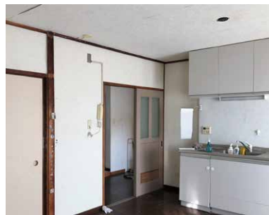
キッチン | 施工前
