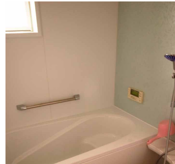
風呂場 | 設備取り替え
