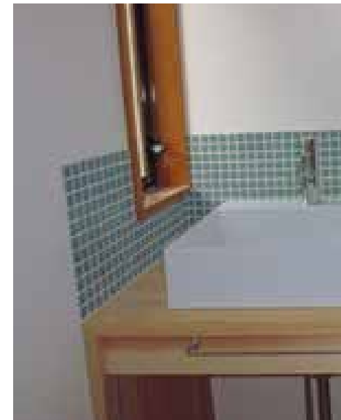
洗面所 | 設備取り替え
