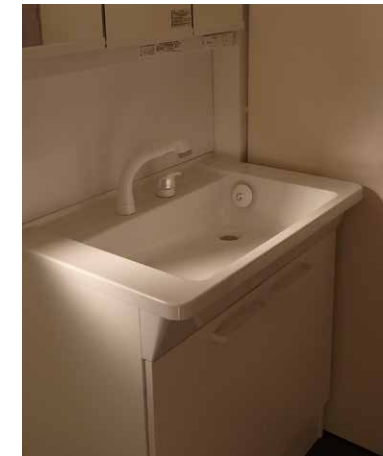
洗面台 | 設備取り替え
