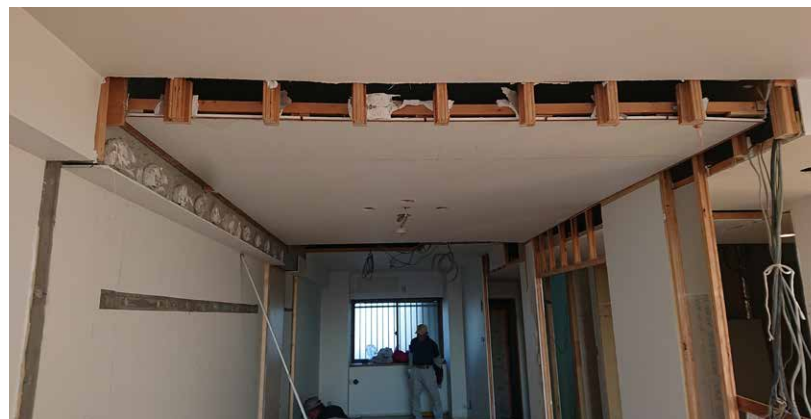
施工中[リビングから北洋室]
