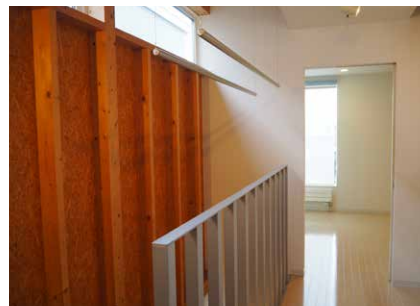
2階廊下 | クロス張り替え
