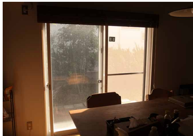
窓 | 二重サッシに交換
