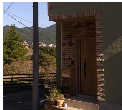
玄関扉 | 交換 外壁 | 塗装
