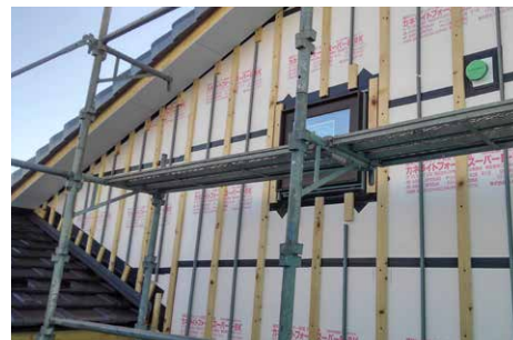
施工中 | 外断熱
