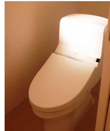
トイレ | 設備取り替え
