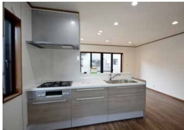
72 キッチン | 設備交換・床張替え
