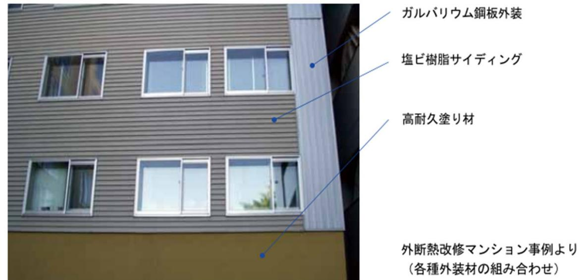
図2 高耐久外装モデルの一例(できるだけシーリング材を使わない工法)
